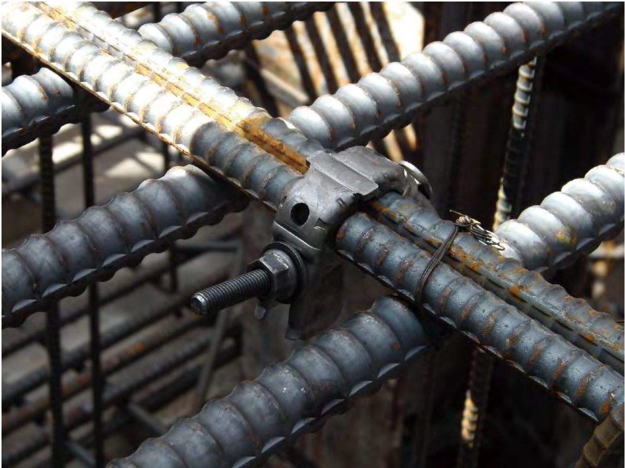
コンクリート側圧による進行方向の鉄筋ズレ防止
