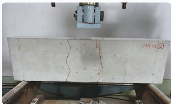
プレーンコンクリート ひび割れ2本
