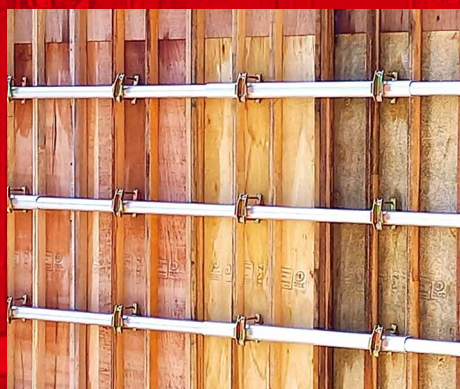
型枠一本締め工法
