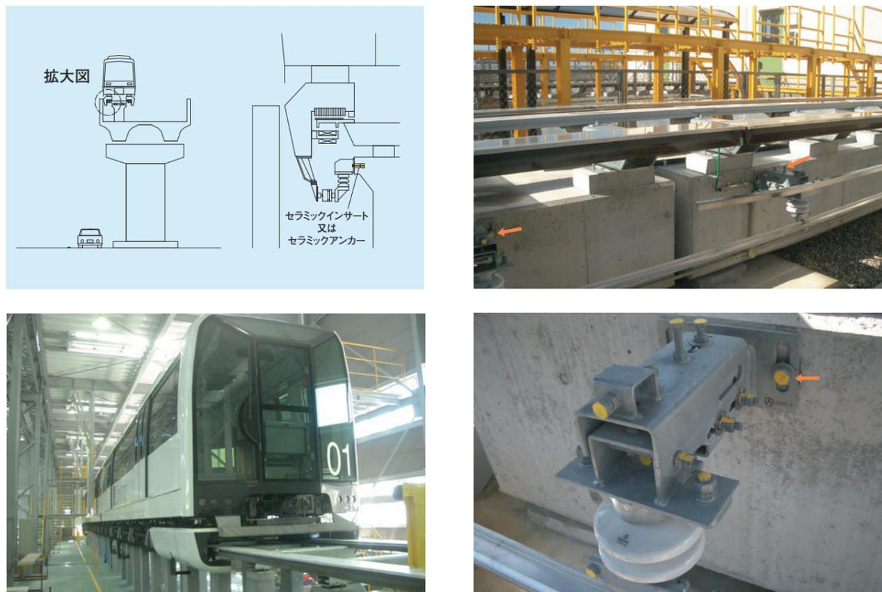
セラミックインサート／セラミックアンカーは絶縁を目的とした箇所にも使用されています。また、金属ボルトや鉄筋などとの接触による電食(異種金属間接触腐食)が起こりません。
